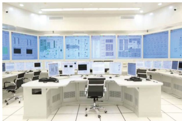
Hệ thống mô phỏng đầy đủ lò Hualong One tại nhà máy Phúc Thanh
