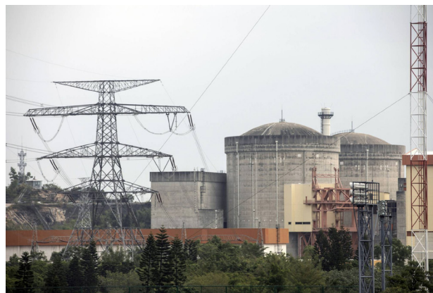
Nhà máy điện hạt nhân Vinh Daya, do Tập đoàn điện hạt nhân Trung Quốc và CLP Holdings Ltd. điều hành | BLOOMBERG
