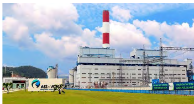
Hình 1. Tổ hợp nhà máy nhiệt điện Mông Dương II - Quảng Ninh
